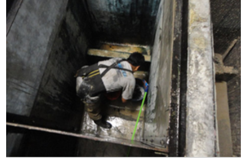
LIMPIEZA DE TRAMPAS DE GRASA Y POZOS SÉPTICOS
