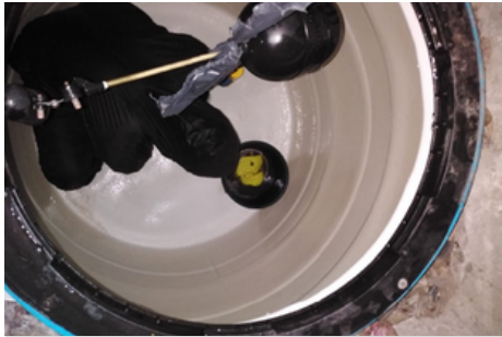
LIMPIEZA DE TANQUES
