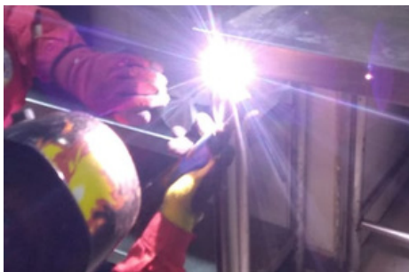
ESTRUCTURAS METÁLICAS Y CERRAJERÍA
