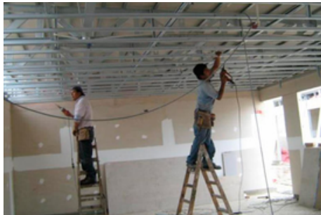
CARPINTERÍA Y DRYWALL
