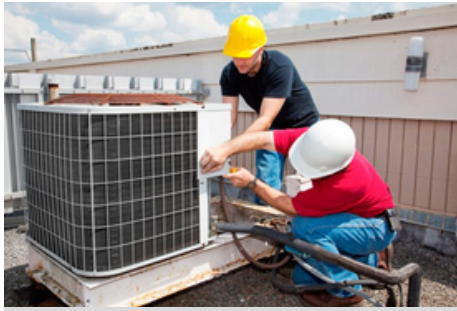
AIRE ACONDICIONADO Y EXTINTORES
