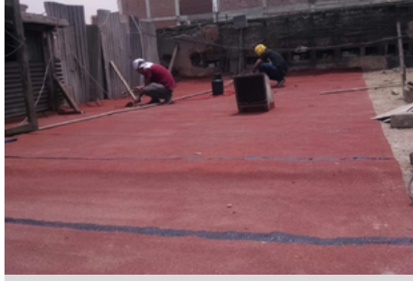
IMPERMEABILIZACION DE TECHOS
